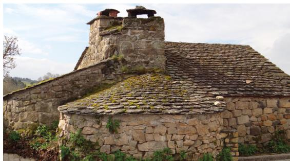
Par crainte des incendies, les fours collectifs forment une construction indépendante des autres habitations. Bâtiments trapus, massifs, ils sont la plupart du temps construits sur le même plan : ils se composent d'un hangar en toit charpenté ou voûté couvert de lauze, ainsi que d'une chambre de chauffe protégée par des murs maçonnés et toujours voûtée permettant de mieux diffuser la chaleur.
